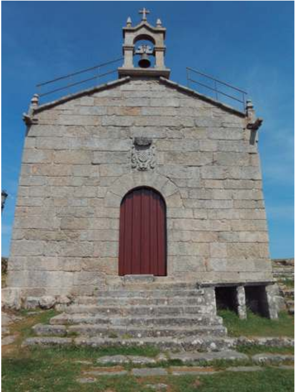
La Ermita de Nuestra Señora del Alba, en la cima del monte del mismo nombre ubicado en el coto de Valladares, lugar donde se cree se asentaba la fortaleza primitiva de la Casa de Valladares. Esta hermita fue reedificada en el último tercio del siglo xvii por el I marqués de Valladares. En su fachada, el escudo de armas de Valladares con la corona de marqués.
