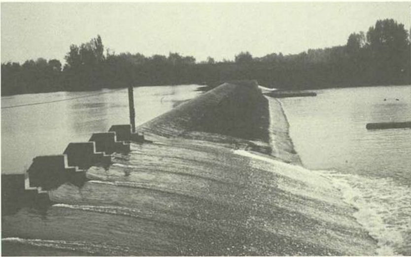
Presa de Pignatelli sobre el Ebro, arranque del canal imperial de Aragón, construida a finales del siglo XVII.
