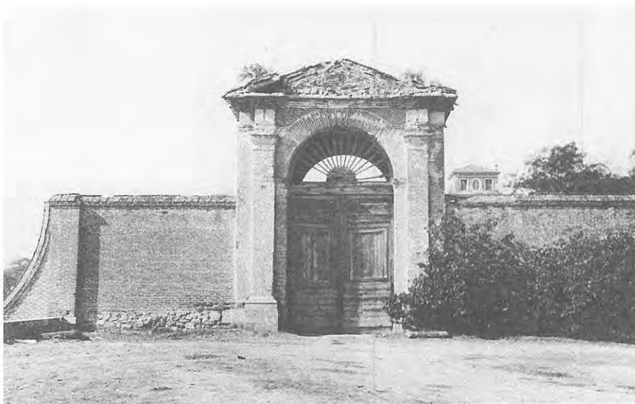
Portalón nordeste de acceso lateral a la primera terrace Foto: J.C.M.
