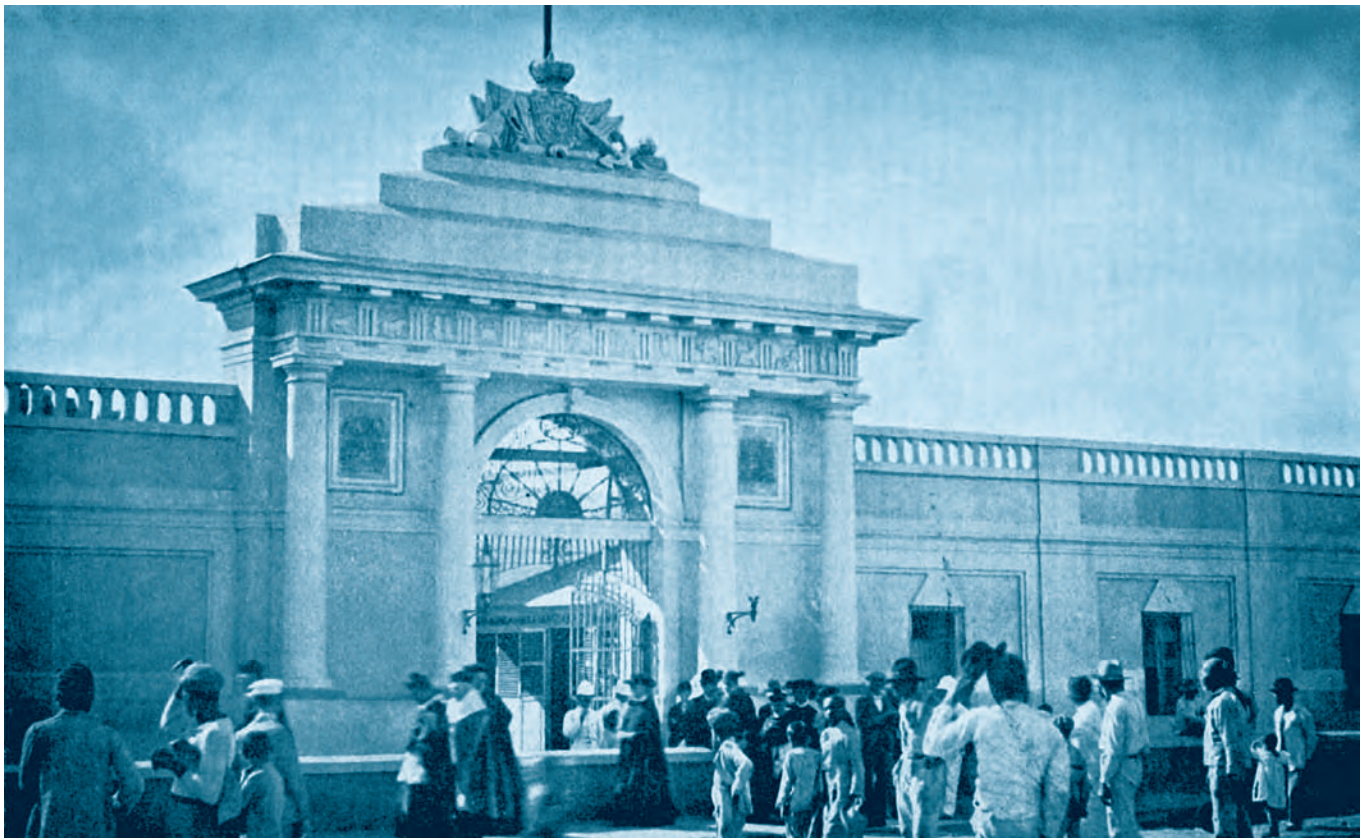
Puerta principal del Arsenal. Departamento de Marina
